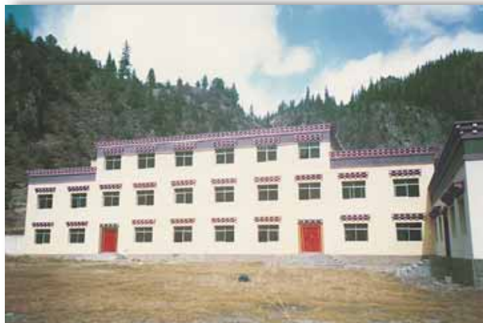
Le bâtiment central comprenant 8 salles de classes et les bureaux - l'aile droite abrite la cuisine et le réfectoire - mars 2009
